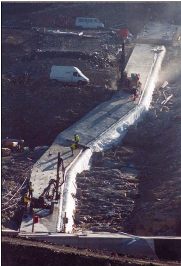
Lignes de forages du voile d'injection
