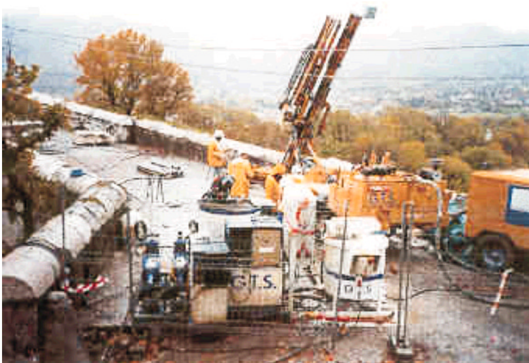
Atelier de forage et centrale d'injection
