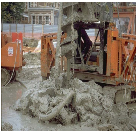
Fin du bétonnage
