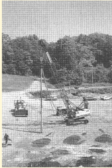
Chantier de vibrocompactage
