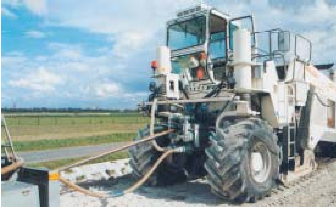
Incorporation de ciment avec apport simultané d'eau par le WR 2500 dans un mélange d'enrobés, de sable et de granulat.
