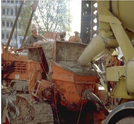
Le béton est livré par la toupe dans la pompe à béton
