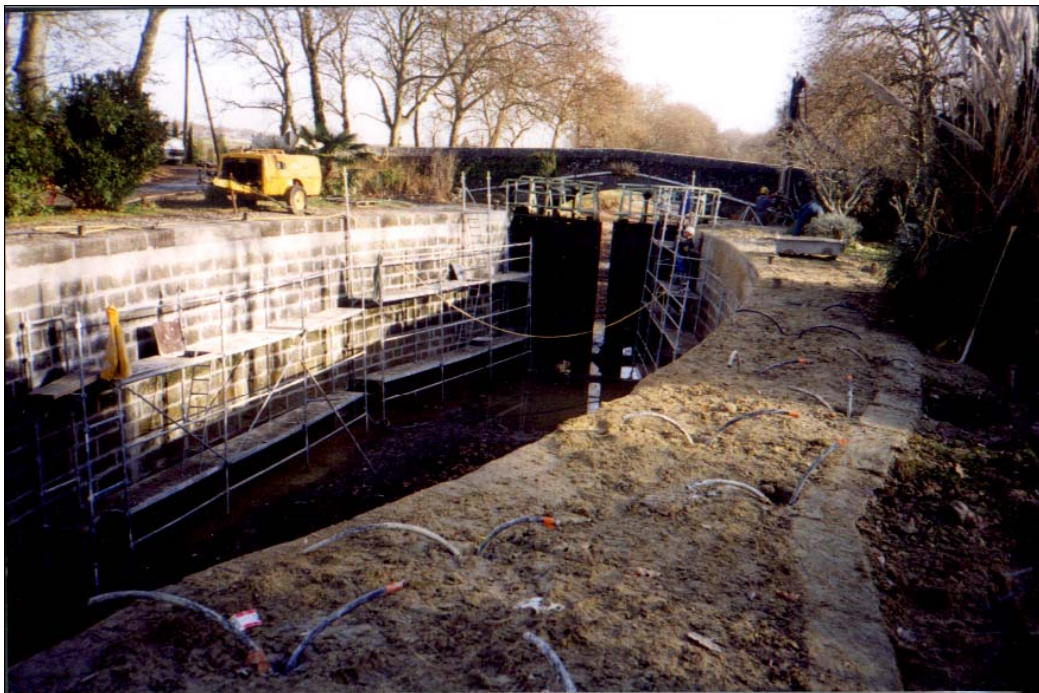
Consolidation des murs bajoyers d'une écluse
