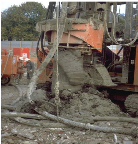
Réalisation du bétonnage
